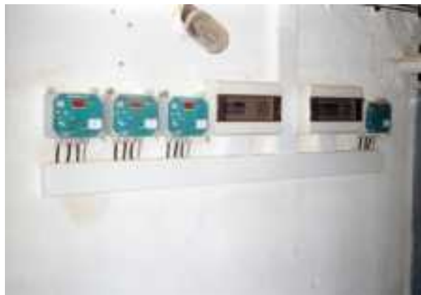
Obr. 4: Řídící jednotka pro vytápění a ventilaci
