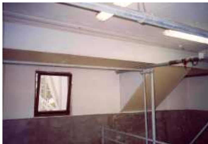
Obr. 3: Přívod čerstvého vzduchu z perforovaných stropních kanálů
