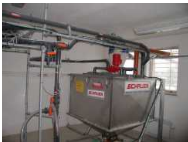
Obr. 5: Nerezová míchací nádrž k přípravě mokrého krmení
