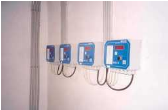
Obr. 4: Řídicí jednotky ventilace stájí
