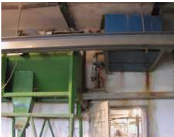
Obr. 1. Nevhodně umístěné a neuzavřené expanzní nádrže a jiné rezervoáry vody jsou častým místem výskytu mykobaktérií v sedimentu
